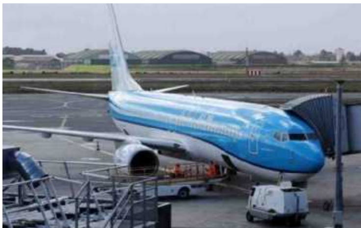
En haut, la nouvelle jetée Satellite 3 en construction. En bas, un avion de la compagnie KLM branché à un équipement d'alimentation en « 400 Hertz ». PHOTOS O. D. ET L.T.
